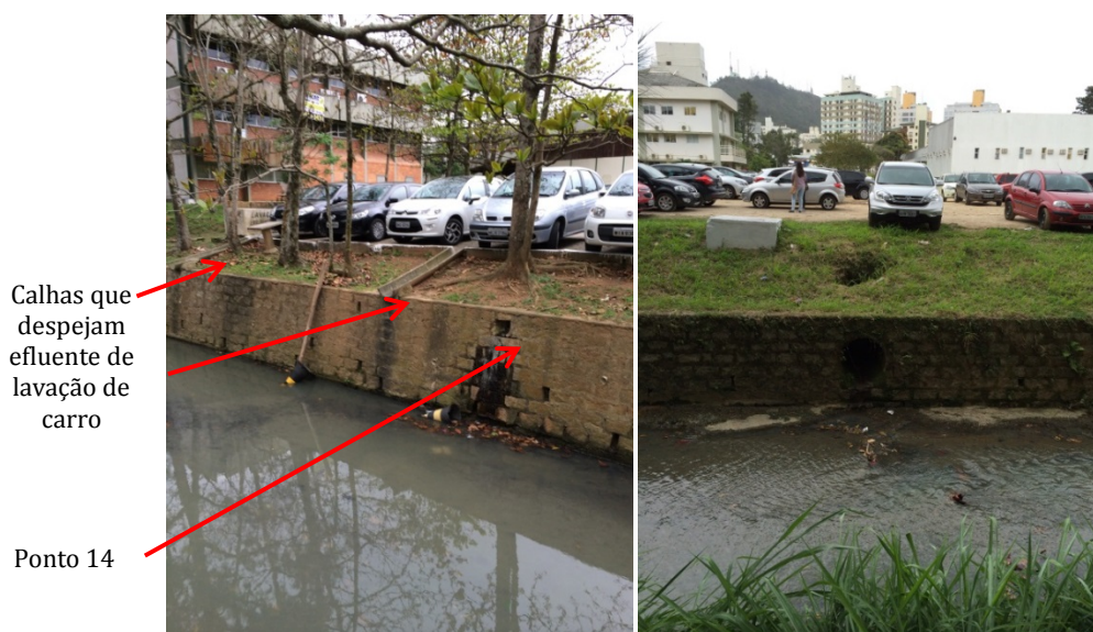
Figura 27 - Ponto 14, calhas com contribuição dos lavadores (esq.) e ponto 16 (dir.) do Trecho 3
