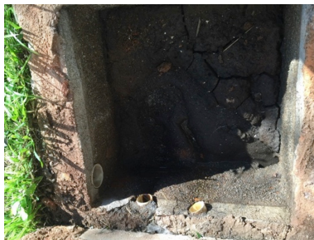
Figura 1 - Caixa que recebe efluente do LIMA
