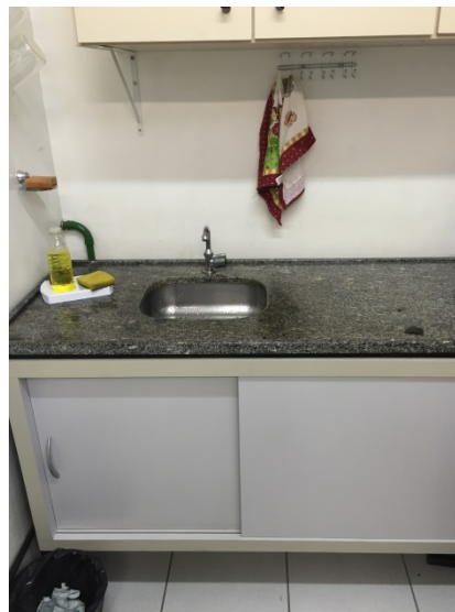
Figura 19 - Pia do Magma ligada de forma irregular na rede de drenagem
