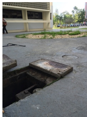
Figura 2 - Situação da caixa compartilhada por esgoto e pluvial
