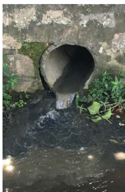
Figura 47- Condição de escoamento: contínuo alto
