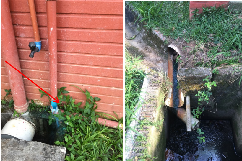
Figura 18 - Despejo do efluente do Magma na rede de drenagem
