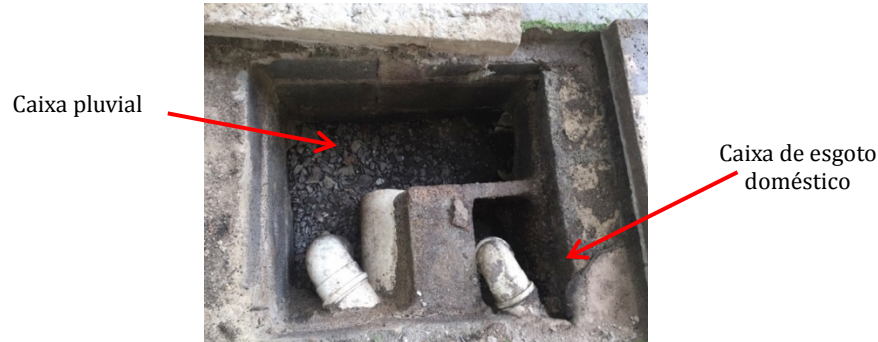
Figura 3 - Caixa compartilhada por efluente de esgoto e pluvial
