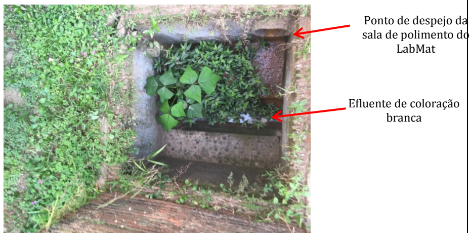
Figura 14 - Despejo de efluente do LabMat na caixa de passagem da rede pluvial
