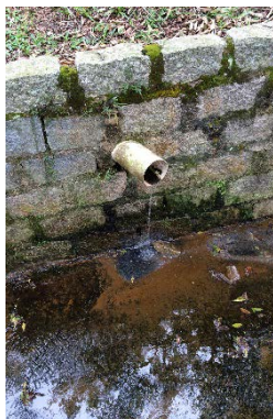
Figura 45 - Condição de escoamento: filete
