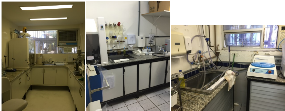
Figura 17 - Pias das salas do CERMAT ligadas na rede de drenagem
