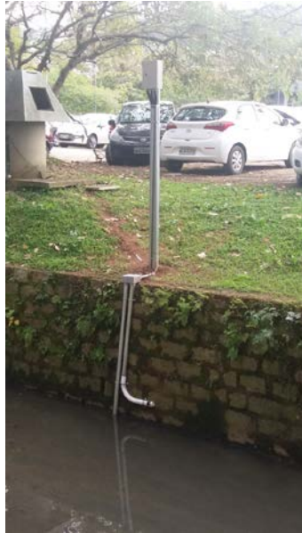
Figura 10. Estação de monitoramento no P1 (Exutório)
