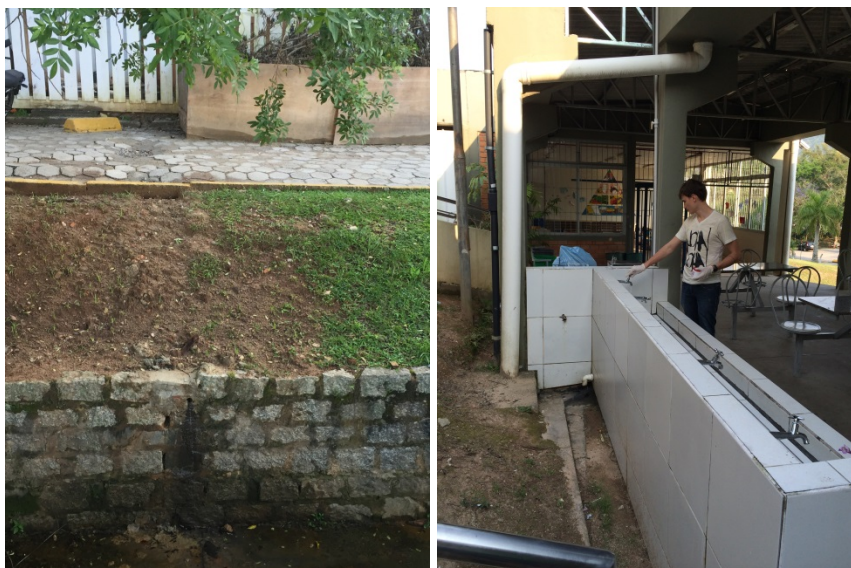
Figura 50 - Obra de ligação dos prédios da civil (esq.) e lavatório do Colégio Aplicação (dir.)
